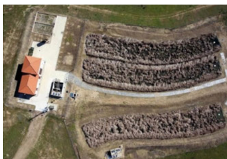
EDAR Garbayuela (Badajoz). Caudal: 151 m 3 /d. Población servida: 700 h-e. Esquema de tratamiento: Tanque Imhoff + Macrófitas en flotación.
