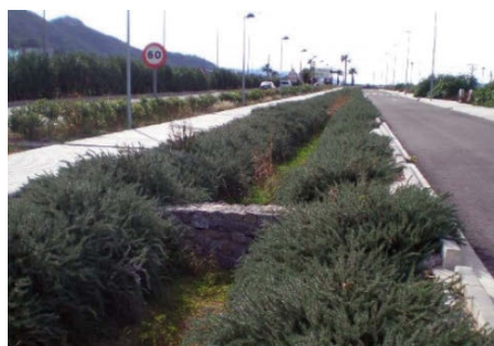
Cuneta vegetada en Rondo Norte (Xàtiva, Valencia)
