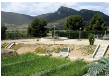
EDAR Higuieruelas (Valencia). Caudal: 222 m 3 /d. Población servida: 302 h-e. Esquema de tratamiento: Aireación prolongada + Humedal de flujo subsuperficial vertical + horizontal. Rendimientos: SS (88%), DBO 5 (93%).
