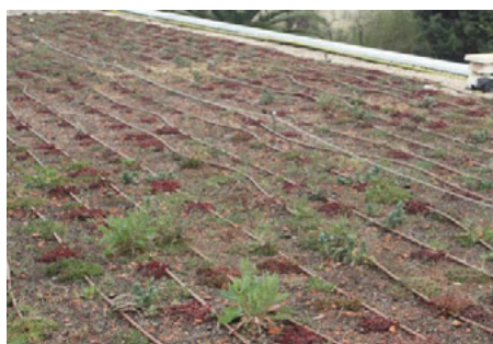
Cubierta vegetada en Colegio Público Gozalbes Vera (Xàtiva, Valencia)
