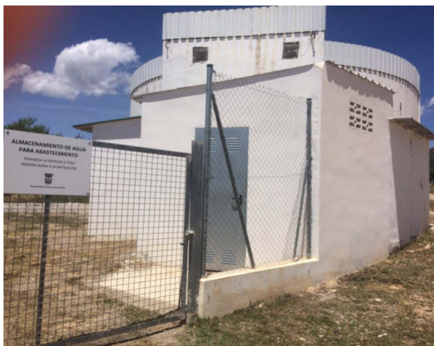
Depósito nuevo de Aras
