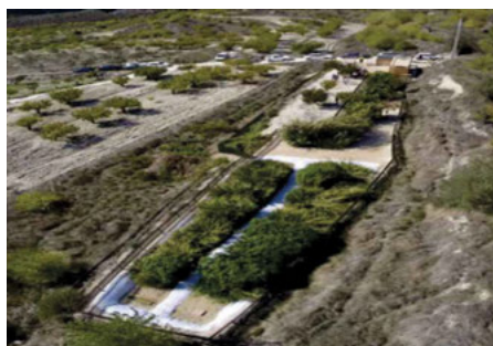
EDAR La Margarida, Planes (Alicante). Caudal: 7 m 3 /d. Población servida: 42 h-e. Esquema de tratamiento: Lecho bacteriano + Humedal de flujo superficial + subsuperficial horizontal. Rendimientos: SS (98%), DBO 5 (99%), DQO (96%).
