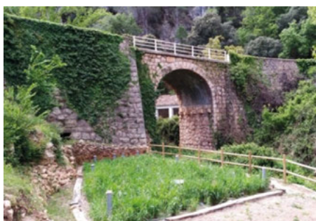
EDAR Fuente la Reina (Castellón). Caudal: 28 m 3 /d. Población servida: 51 h-e. Esquema de tratamiento: Tanque Imhoff + Humedal de flujo subsuperficial vertical. Rendimientos: SS (93%), DBO 5 (94%), DQO (90%).
