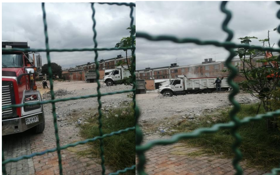
Fotografías 22 y 23. Obras de demolición del Colegio General Santander – julio de 2024
