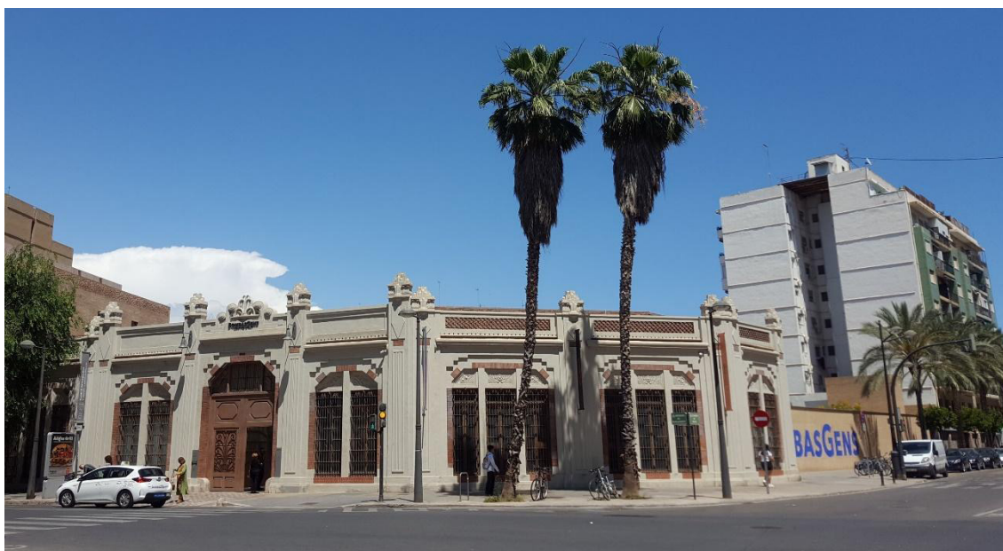
Figura 5. El diseño arquitectónico del Centro de Arte Bombas Gens replantea el original modernista de la antigua fábrica, combina adecuadamente con la propuesta gráfica actual. Fuente: elaboración propia.
