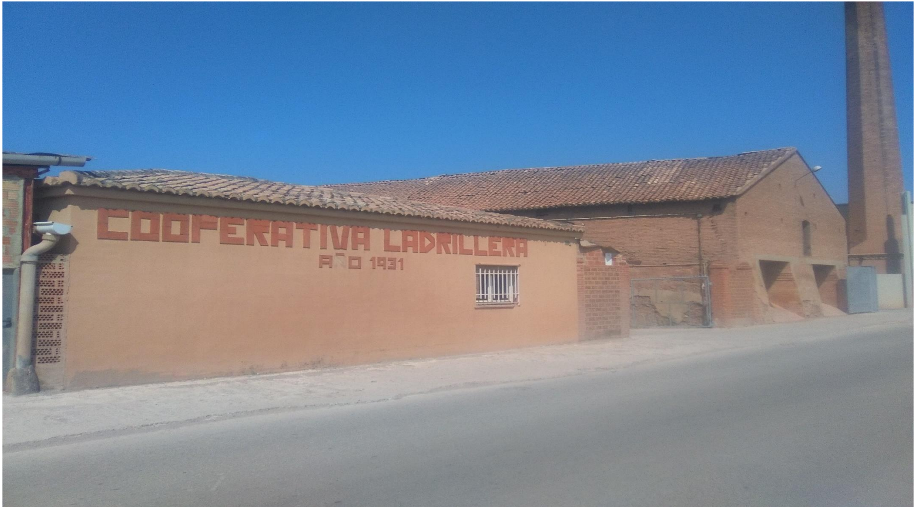
4.3: Fotografia del recinte industrial de la cooperativa rajolera dels «Descamisats».
