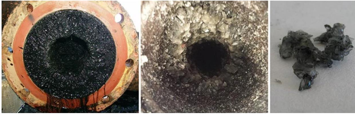
Figura 12. Depósitos de precipitados: (a) Tubería de la línea de fangos con precipitados; (b) Depósito de estruvita (Fuente: PHORWater, s. f.).
