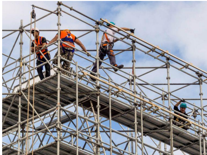
Trabajos en el sector de la construcción
