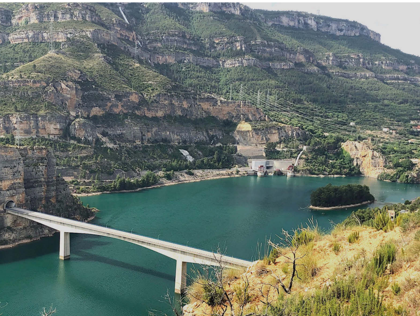
Embalse de Cortes de Pallás, central hidroeléctrica y puente. Foto: Estepa.
