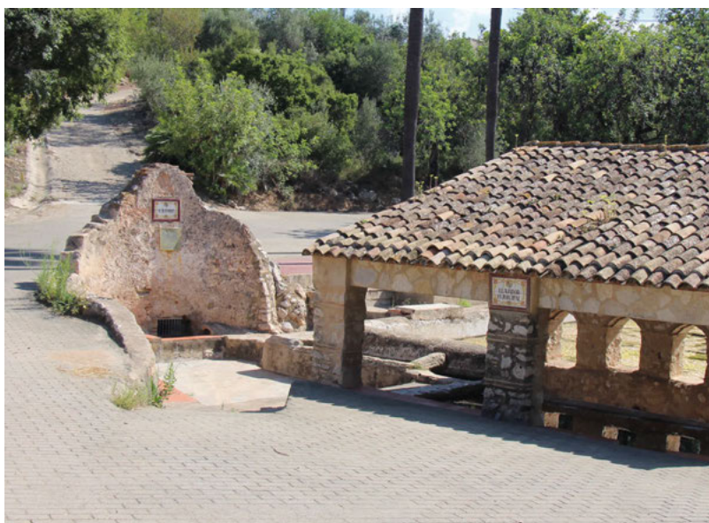
Fuente, abrevadero, lavadero y balsa. Foto: Estepa.
