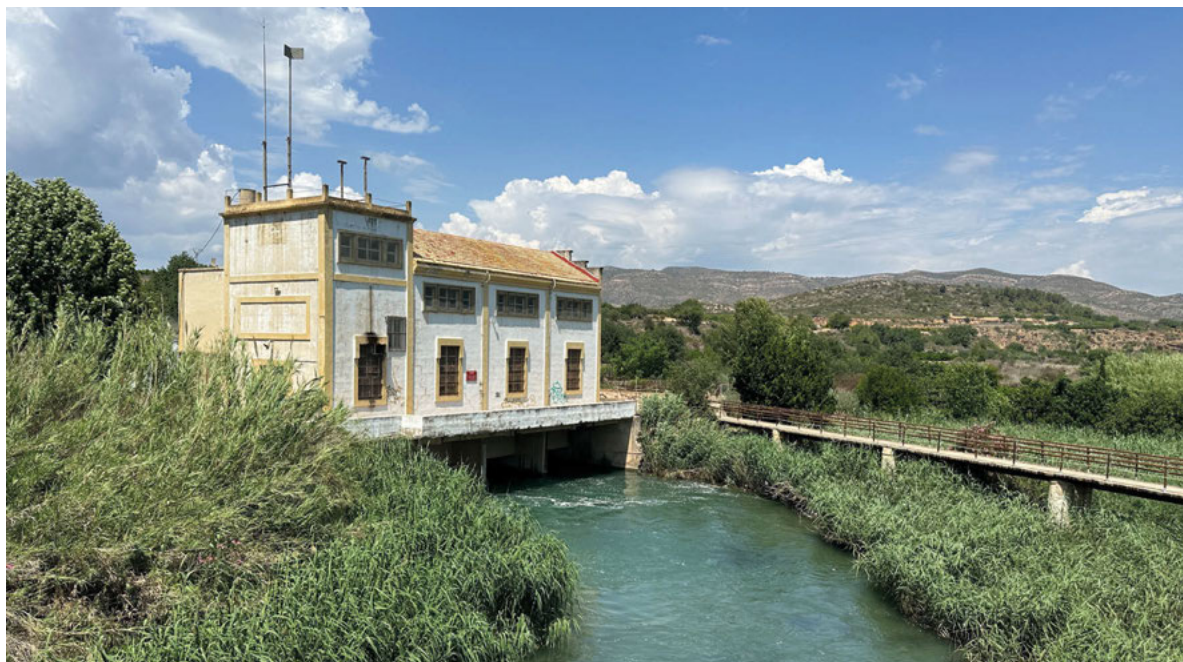
Central hidroeléctrica y pasarela en el Turia. Foto: Ghaleb Fansa.
