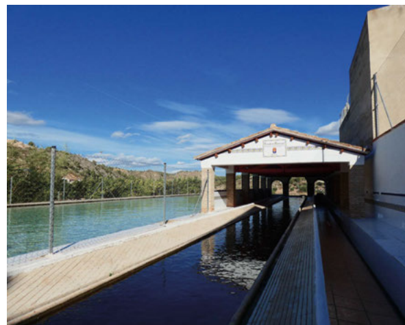
Lavadero Municipal. Foto: Estepa.
