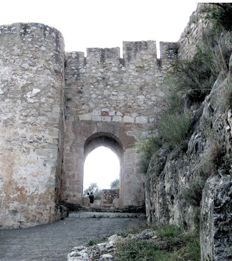
Puerta y torre, Castillo de Chulilla. Foto: J. Montesinos.
