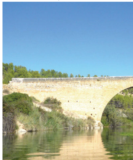
Puente de Vadocañas. Foto: Ayuntamiento.
