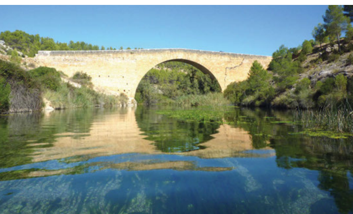
Puente de Vadocañas. Foto: Ayuntamiento.
