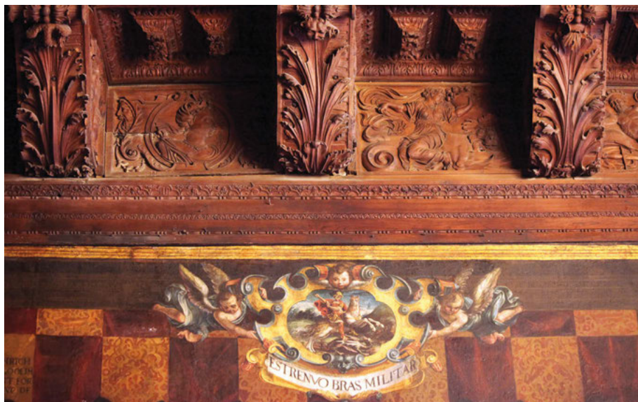
Figura 2. Aspecte de la disposició dels plafons de la base de la tribuna, entre les mènsules.
