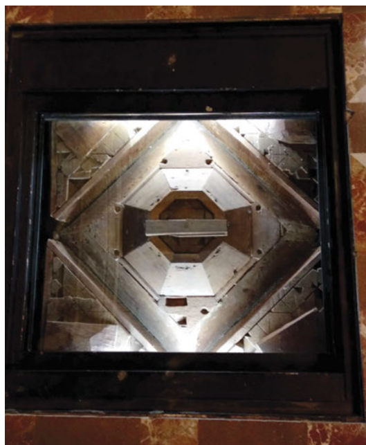
Figura 5. Trasdós del casetón de la Sala Dorada Grande.
