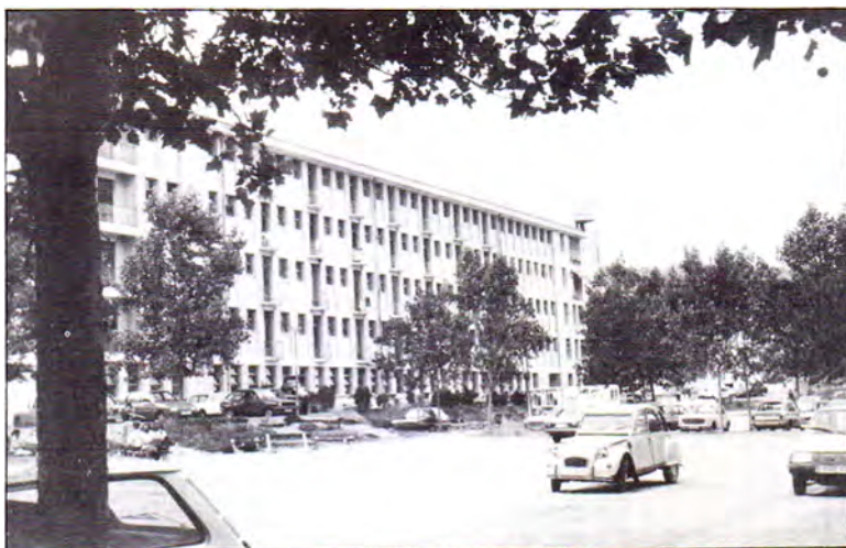
Façana del Lycée Renouvier, seu de l'UCE
