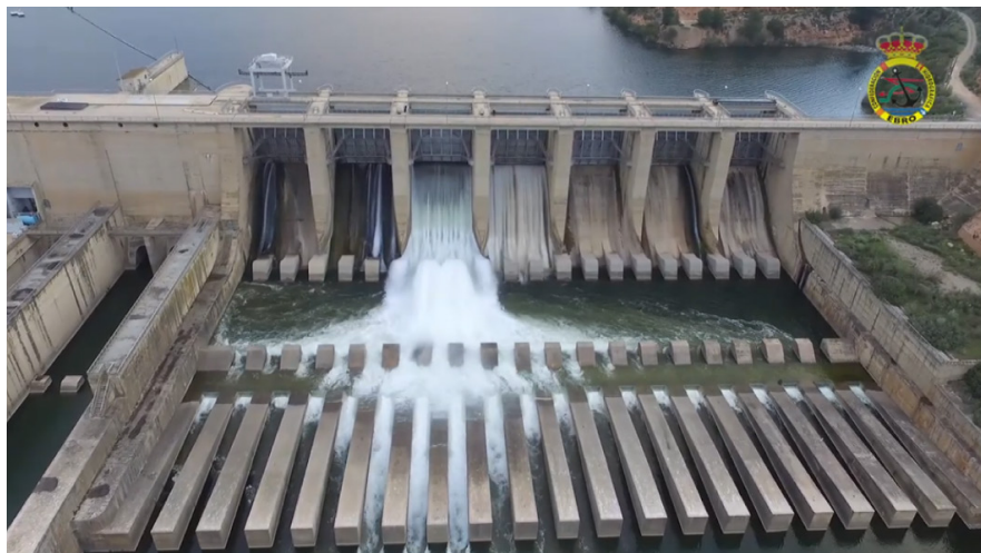
Figura 6 | Aliviadero de la presa de Ribarroja durante las maniobras de apertura.
