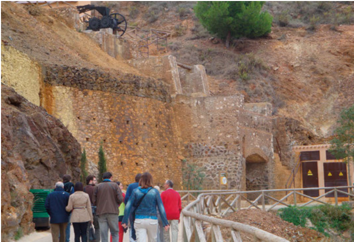
Fig. 2.23. Estructuras mineras en el exterior de la Mina Agrupa Vicenta del Parque Minero de La Unión (Murcia, España) (2010).
