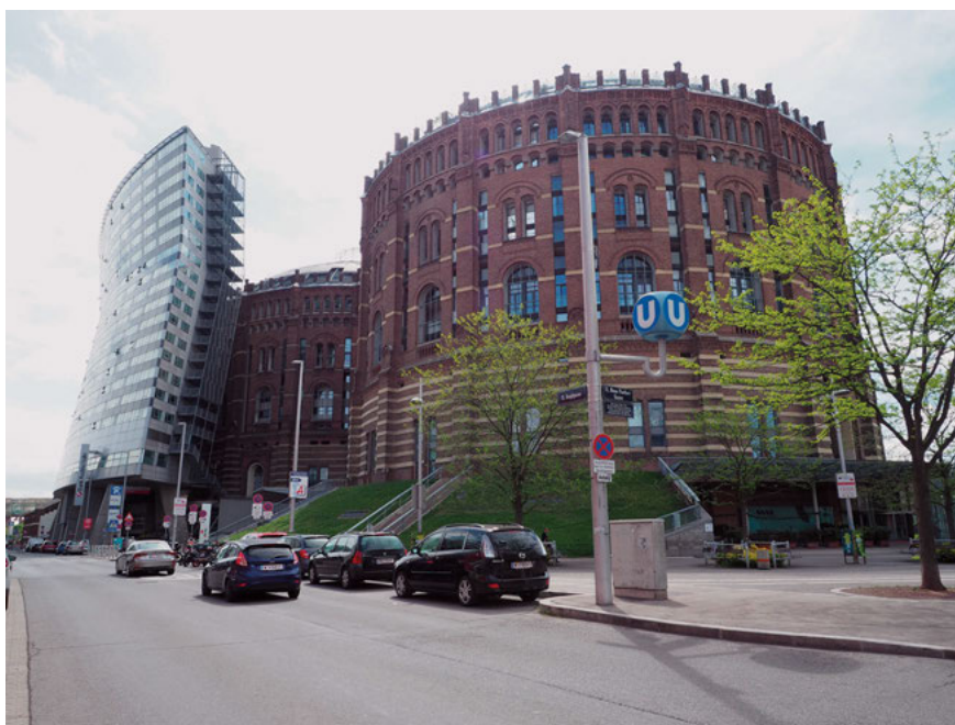
Fig. 2.2. Gasómetros de Viena (Austria) (2017).
