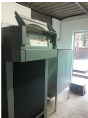
Fotografía 1. Caldera de biomasa y silo de la instalación de calefacción de la guardería.
