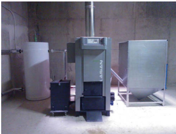
Fotografía 3. Caldera de biomasa poli combustible de 65 kW del edificio consistorial.
