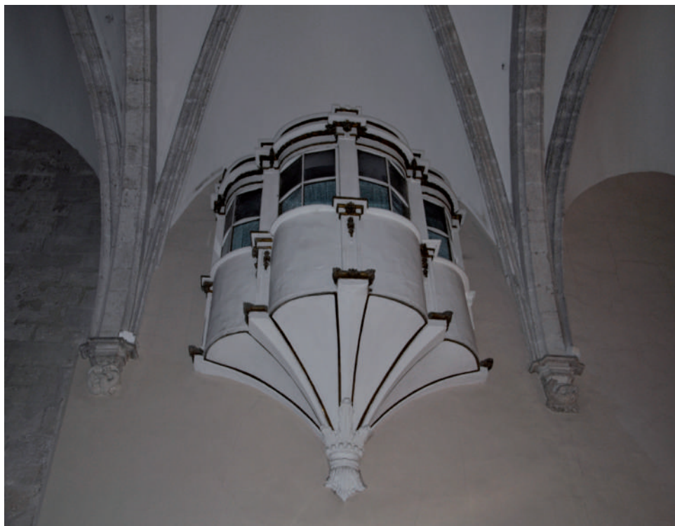
Fig. 4. Ménsulas y arranque de las bóvedas que anteceden a la actual capilla de San Vicente.
