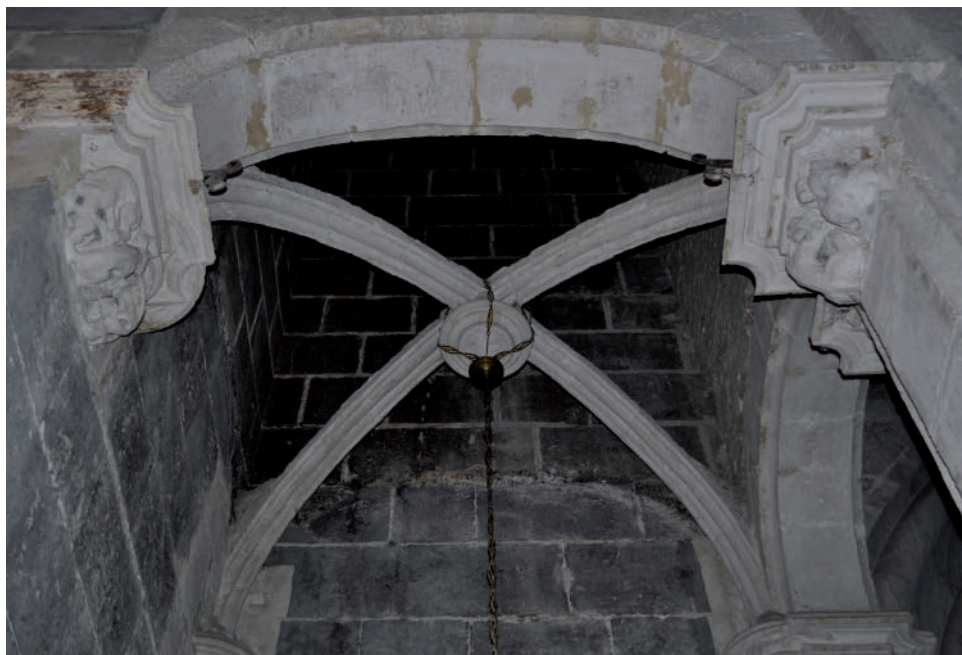
Fig. 6. Bóveda del tramo que antecede a la capilla de los Reyes.
