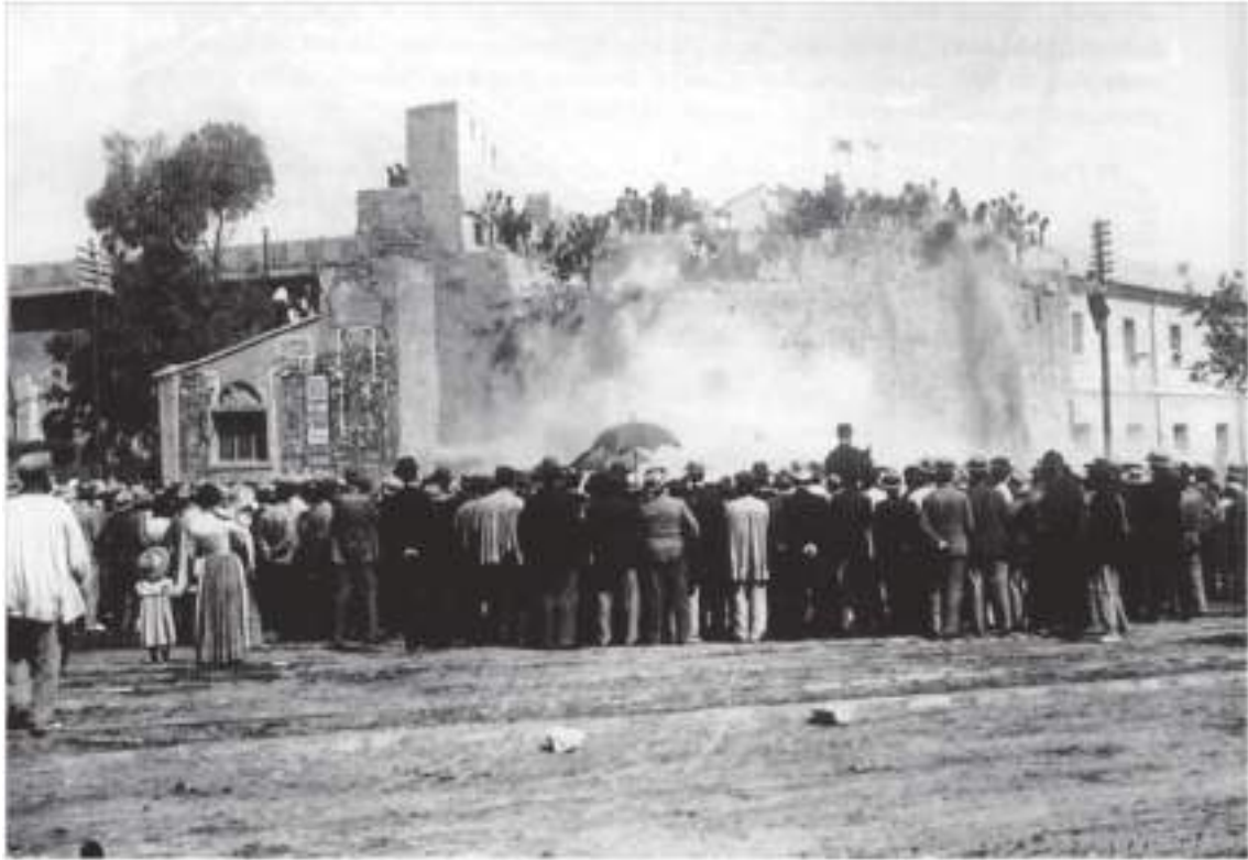
Fig. 3.- Imagen del derribo de las murallas en 1865. Archivo Martínez Aloy.
