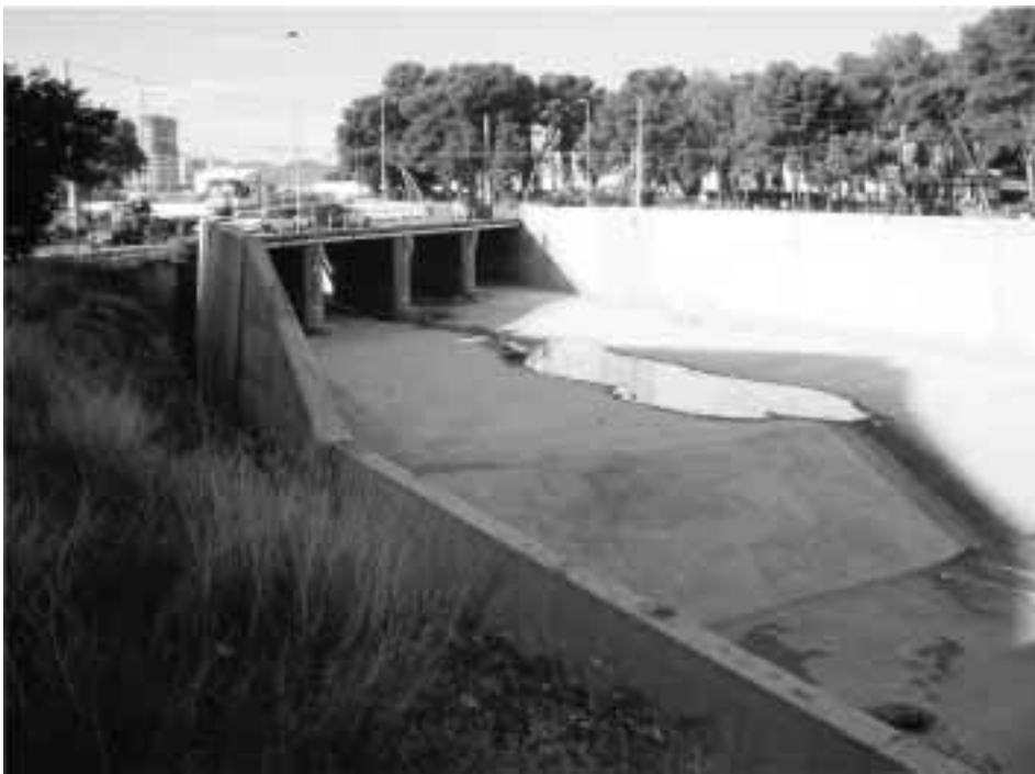
Figura 7. Encauzamiento del Riu Sec de Borriol, aguas abajo del puente del cementerio.
