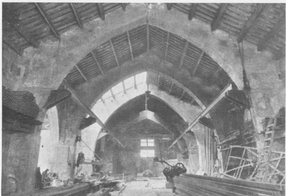
Vista general de la tercera y cuarta naves
