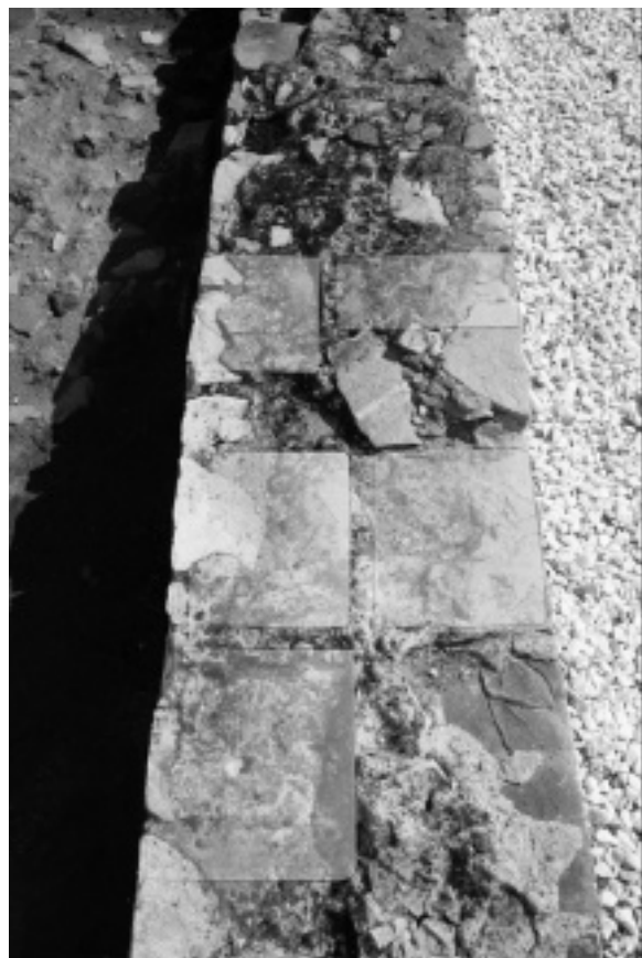
Fig. 14. Muro norte. Detalle con las improntas de ladrillos.
